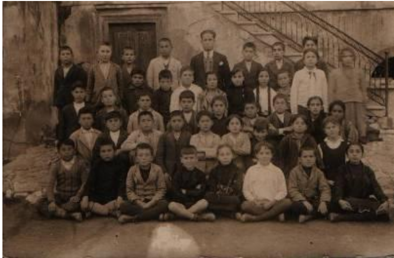
Şimdi Pansiyon Binası Olarak Kullanılan Zübeyde Hanım İlk Mektebi
