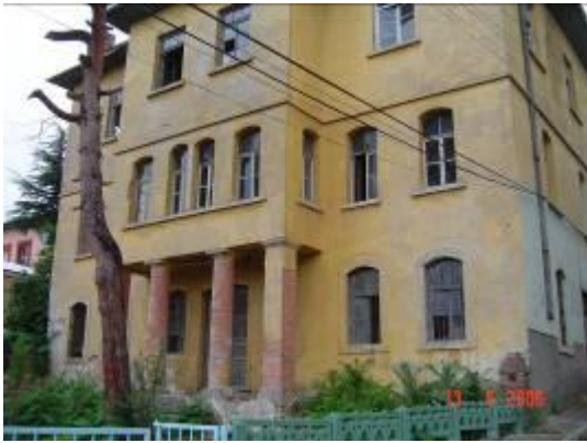
Eski Hükümet Konağı
